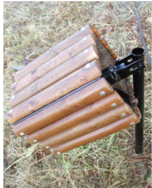
Detalle de vaciado por giro
